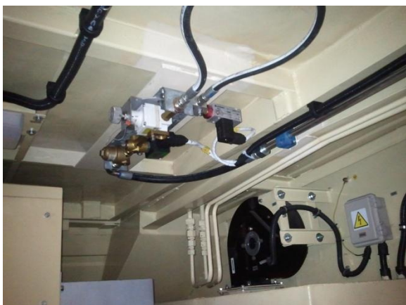
Přemístěná jednotka pod střechu za stanovištěm.
