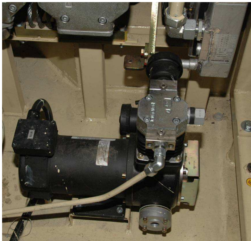
Obr. 20: Pomocný kompresor (–M109)
