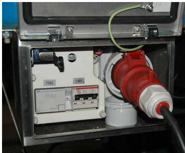
Obr. 61: Box pro připojení vnějšího napájení 3 x 400 V/50 Hz
