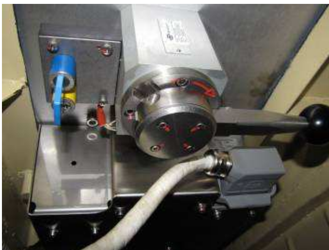
Obr. 60: Ruční uzemňovač střešní VN výzbroje –Q02
