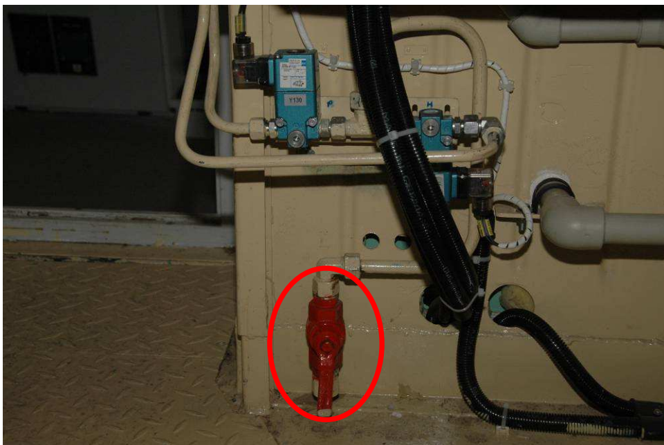
Obr. 26: Kohout vypnutí houkaček a píšťaly
