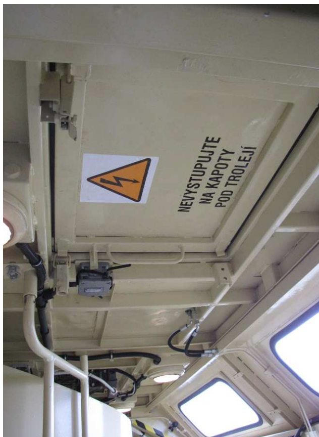
Obr. 47: Výstup na střechu
